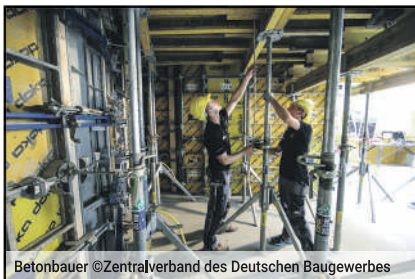
Betonbauer ©Zentralverband des Deutschen Baugewerbes
