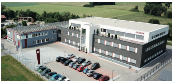
Das über 7.700 m 2 große Elektronik-Service-Center in Pürgen-Lengenfeld.
